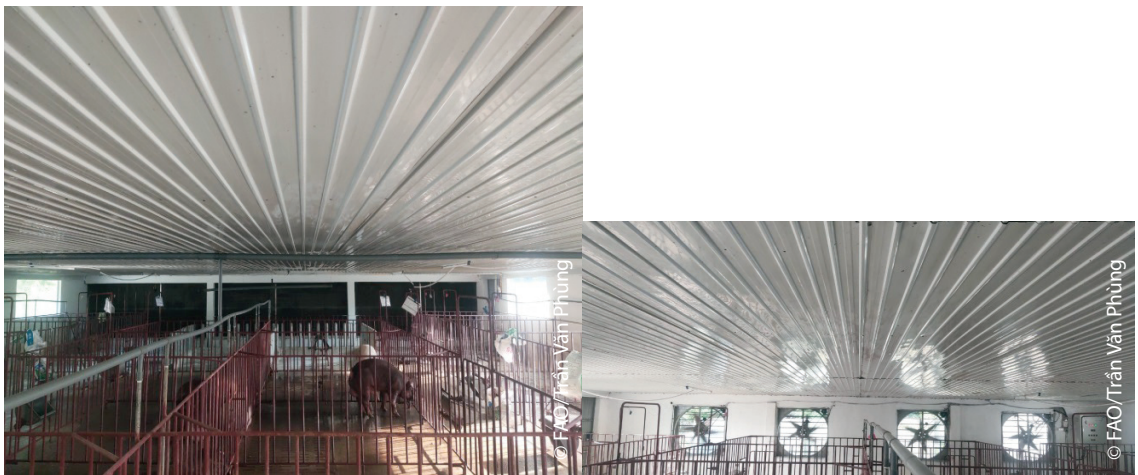
Hình 13. Hệ thống dàn mát và quạt hút trong chuồng nuôi lợn đực giống
