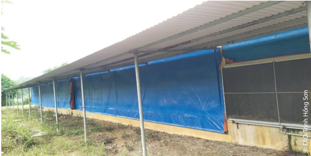
Hình 51. Làm mái che dàn mát và bạt che nắng
