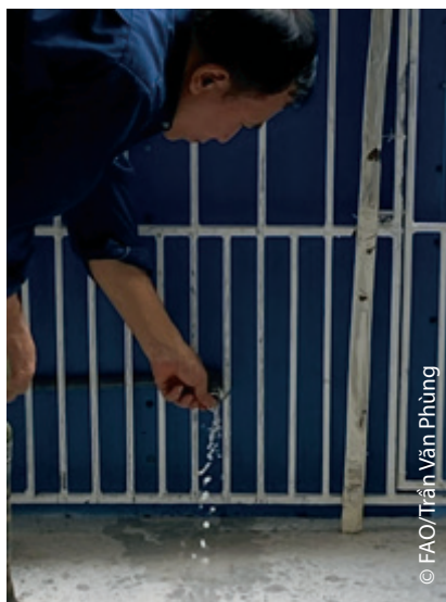
Hình 123. Kiểm tra vòi uống nước
